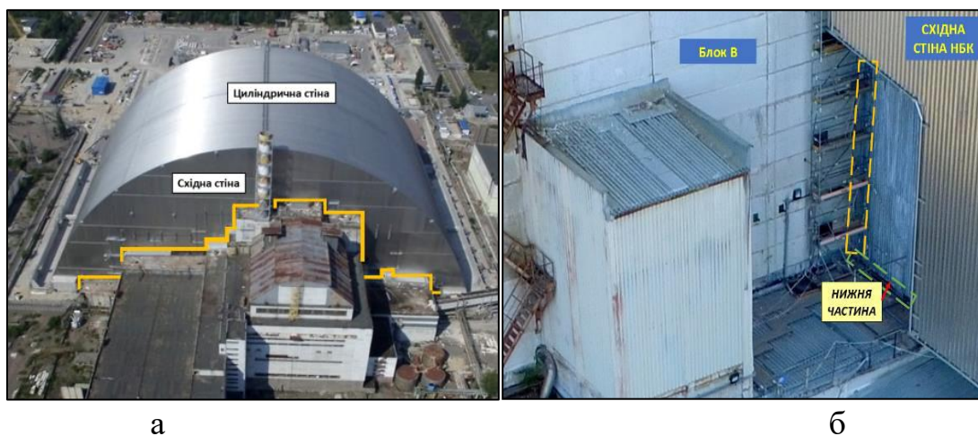
Рис. 1 – Розташування місць протічок повітря з РА в оточуюче середовище (жовтий колір) на фото НБК на східній (а) стороні НБК, а також місця розташування протічок на зовнішній ділянці обшивки вентиляції ДСРВ (б)
