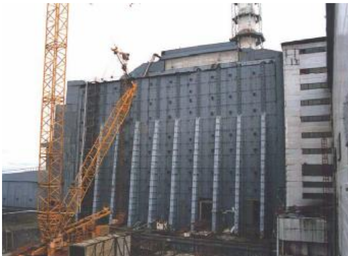
Рисунок 16 – Западная контрфорсная стена
