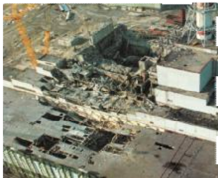
Рисунок 1 – Состояние разрушенных конструкций блока «Б» II-й очереди ЧАЭС
