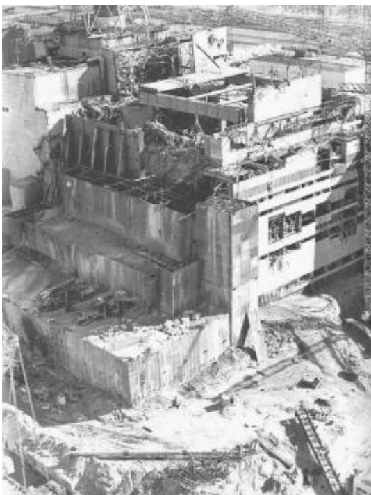
Рисунок 15 – Возведение северной (каскадной) стены объекта «Укрытие»
