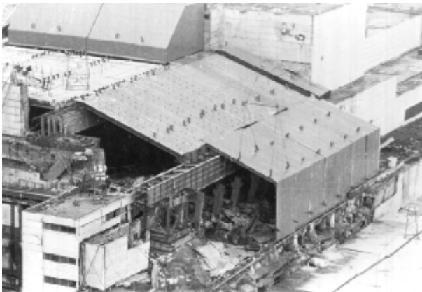
Рисунок 14 – Строительство южной стороны объекта «Укрытие»
