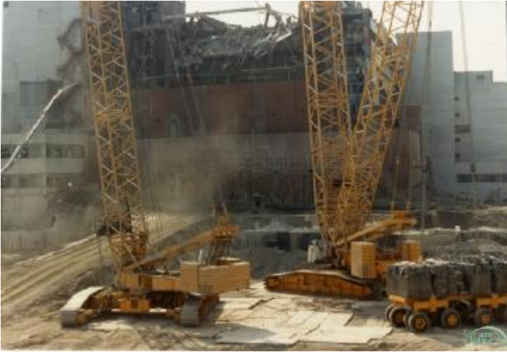
Рисунок 17 – Гусеничные краны «Demag» на строительстве объекта
