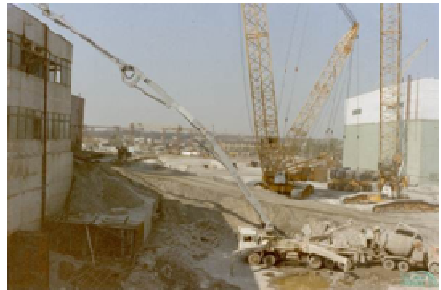
Рисунок 19 – Бетононасос «Putzmeister» в работе у 4-го блока
