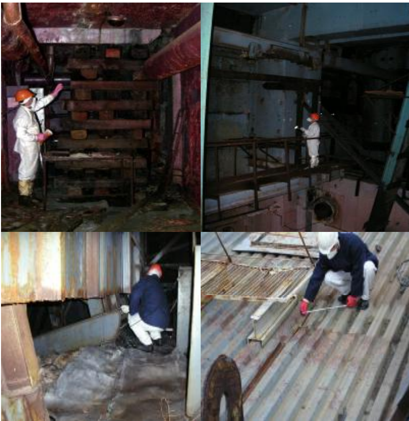
Рисунок 4 – Визуальный осмотр конструкций
