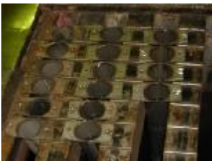
Рисунок 5 – Размещения пеналов с ОТВС в отсеках бассейна выдержки
