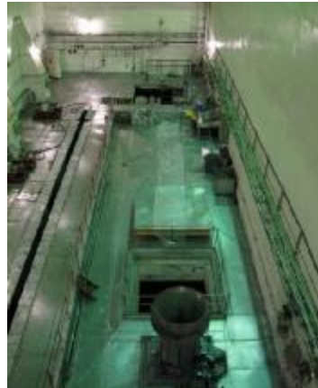
Рисунок 4 – Общий вид помещения 319, где выполняются основные операции по обращению с ОТВС: приемка, подготовка к хранению, выгрузка
