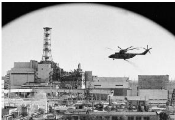
Рисунок 3 – Забрасывание реактора материалами с вертолетов
